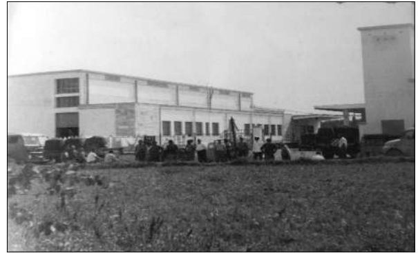
Lavori in cantina
