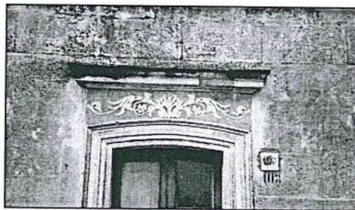
Tecnica dell'intonaco graffiato
