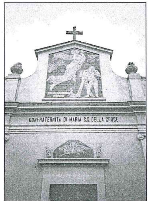
Tecnica dell'intonaco graffiato
