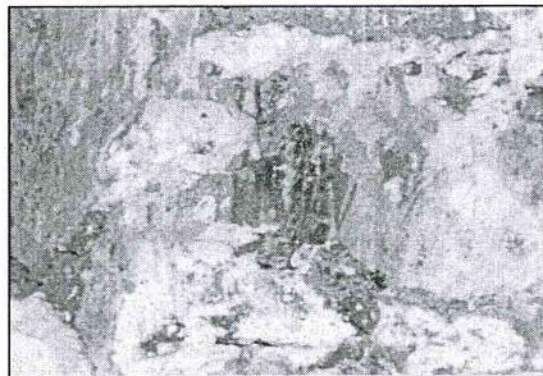
Resti di affresco rinvenuti nella stanza centrale parete destra entrando: c'è da ritenere che si tratti della stanza più antica
