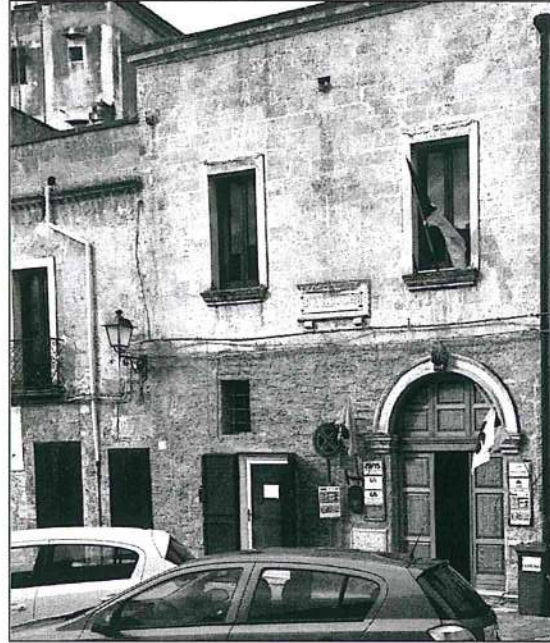
Il palazzo delle Ente Rini in piazza IV novembre recuperato e restaurato negli anni della sua presidenza dell'Ente
